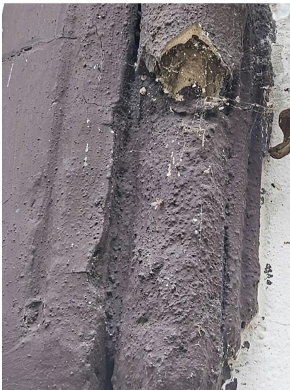
Zdjęcie nr 19. Uszkodzenia detali drewnianych
