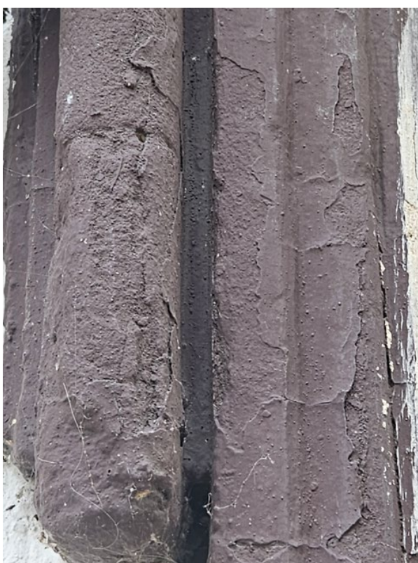
Zdjęcie nr 20 Uszkodzenia detali drewnianych
