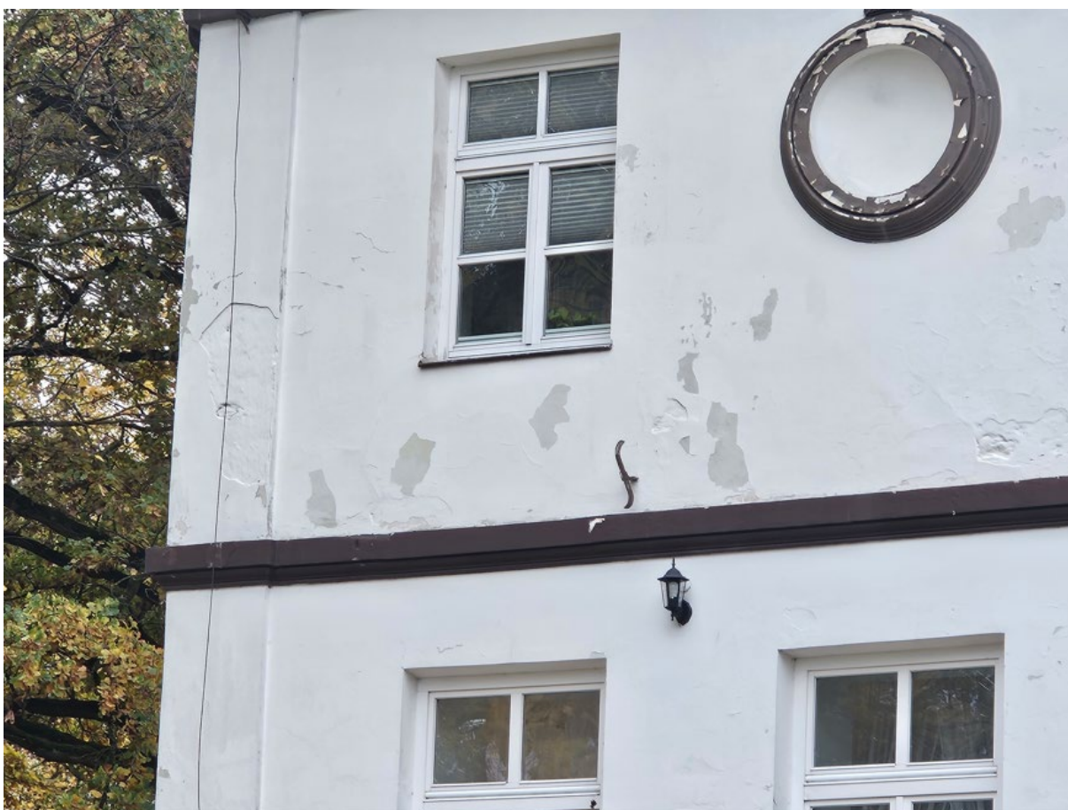
Zdjęcie nr 6. Złuszczone warstwy malarskie oraz zawilgocenia na zewnętrznej budynku – ściana wschodnia
