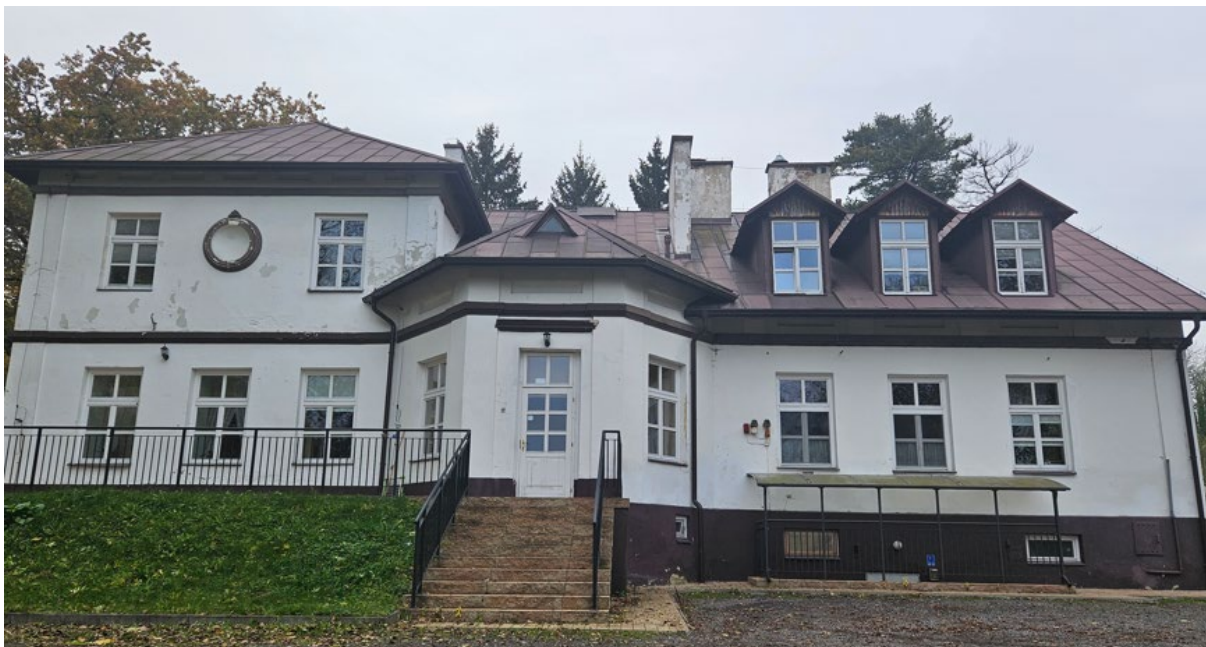
Zdjęcie nr 5. Złuszczone warstwy malarskie na zewnętrznej ścianie budynku – ściana wschodnia
