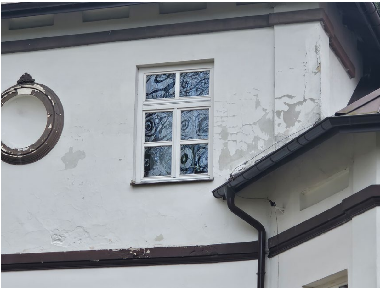
Zdjęcie nr 4. Złuszczone warstwy malarskie oraz ślady wilgoci na zewnętrznej ścianie budynku
