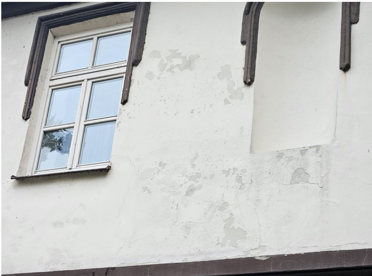
Zdjęcie nr 11. Fragment ściany zachodniej – widoczne skutki działania wody
