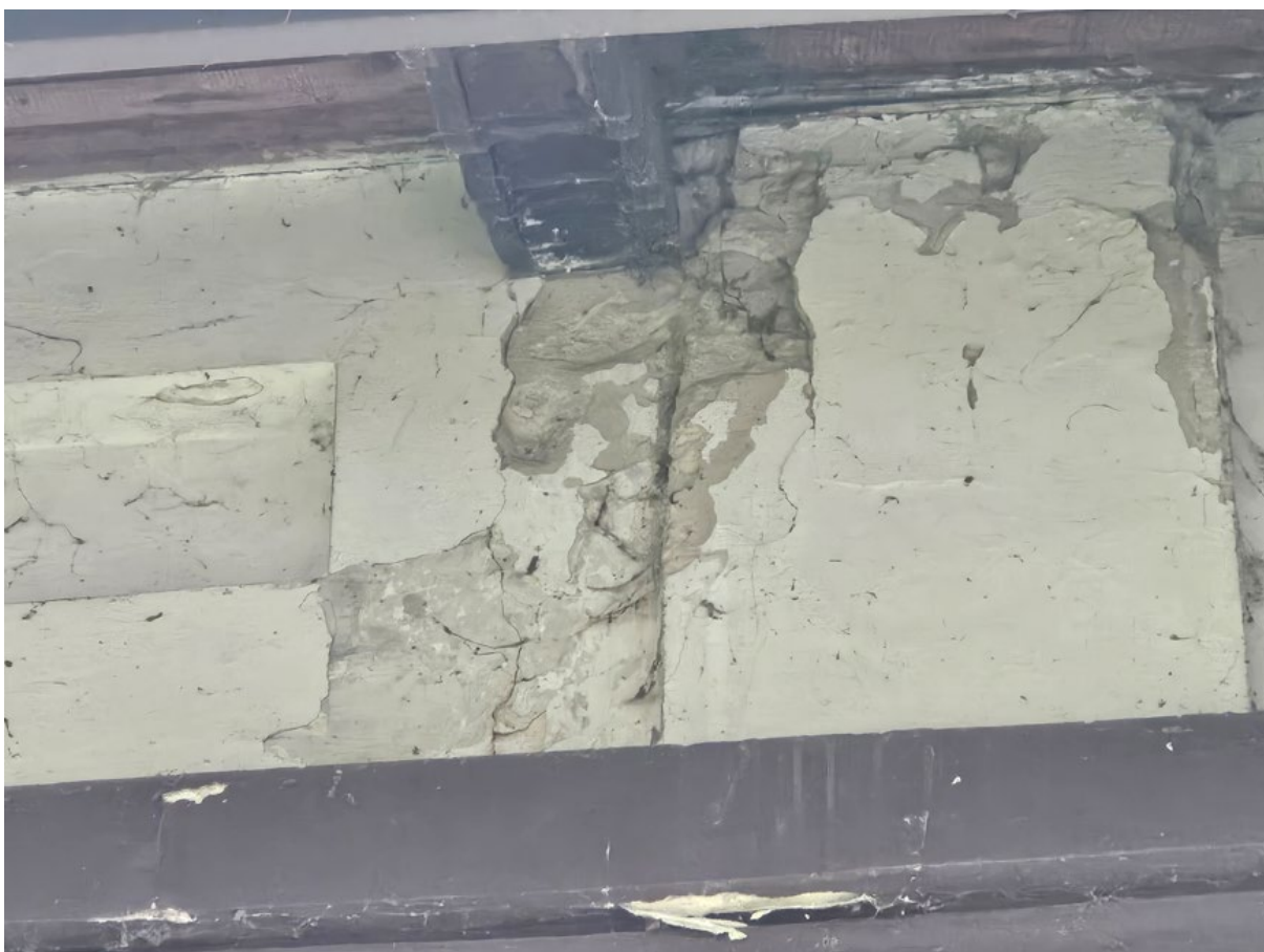
Zdjęcie nr 14. Fragment ściany pod okapem dachu – widoczne skutki działania wód opadowych
