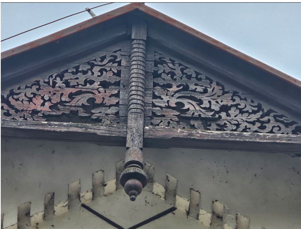
Zdjęcie nr 22. Fragment ozdobnych drewnianych detali dachu
