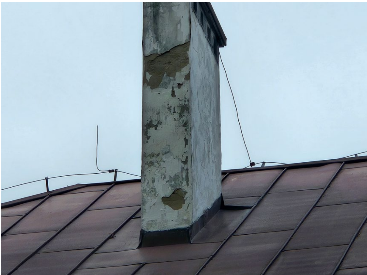
Zdjęcie nr 9. Fragment komina – widoczne ubytki tynku i zawilgocenia
