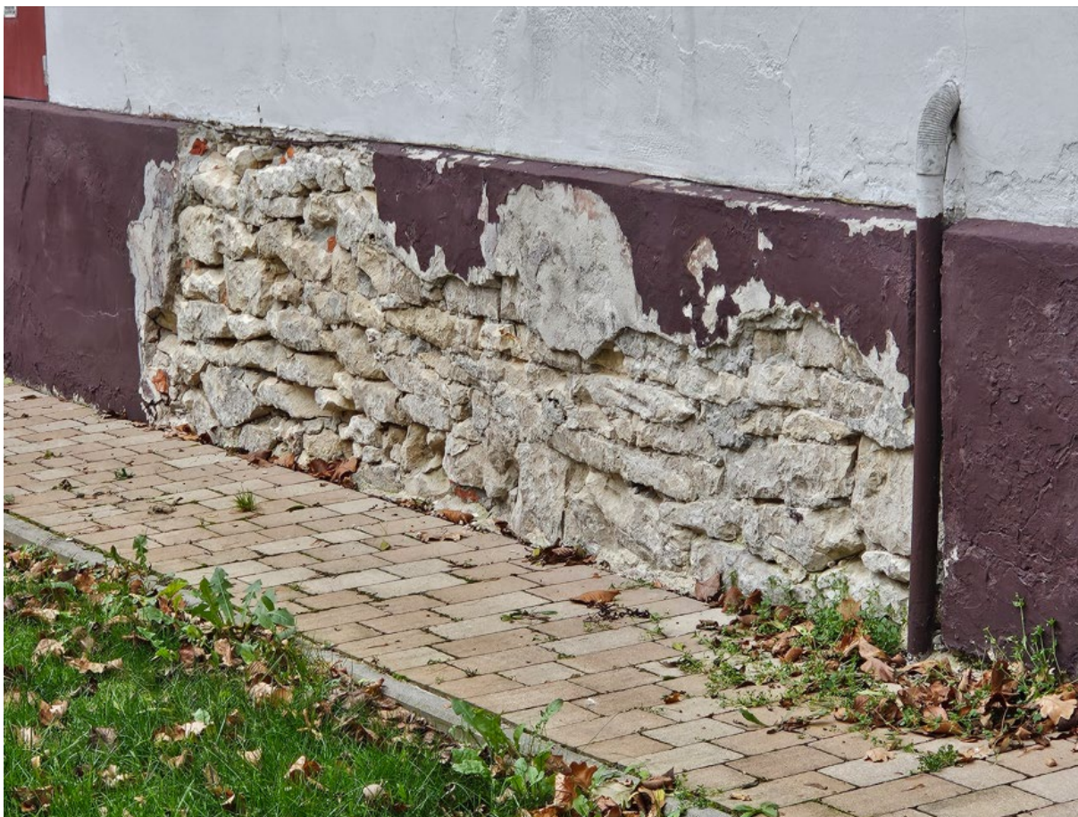
Zdjęcie nr 10. Fragment cokołu budynku – widoczne ubytki i uszkodzenia tynku w strefie cokołowej
